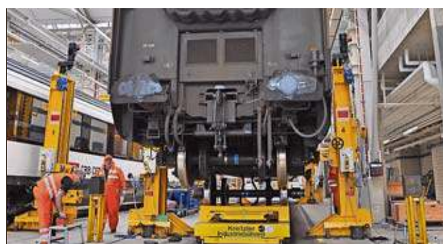
Bis zu zehn Wagen werden hier täglich repariert.
