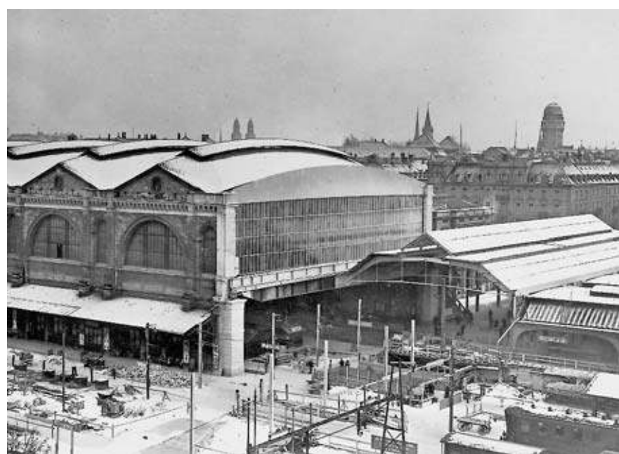
Die heute noch bestehende Querhalle wurde 1930 gebaut.
